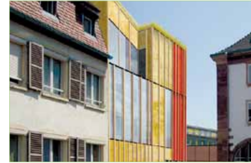
4 logts, Tour des pêcheurs, Dominique Coulon arch.
