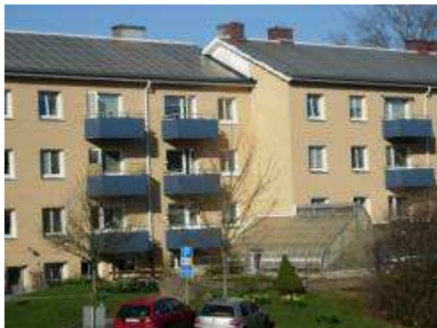
Photo 1 : La maison solaire de Järnbrott, transformée en 1987 (photo Paula Femenías, 2005)
